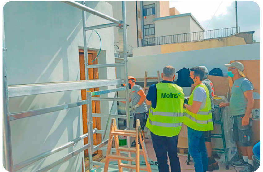
Fig. 12: Inspección técnica en obra
