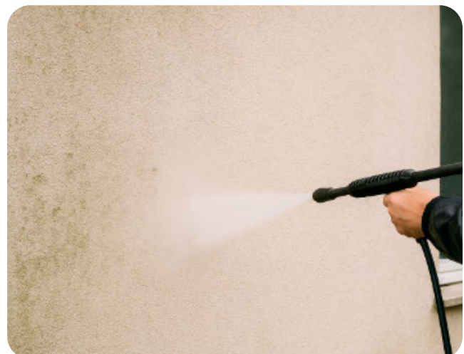
Fig. 4: Limpieza del moho en fachada
