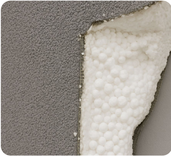
Fig. 26: Detalle de una capa base de bajo espesor,
