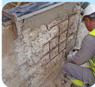
Reparación y protección del hormigón
