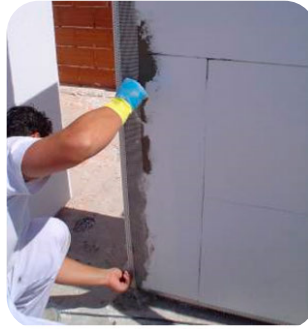
Fig. 15: Aplicación de perfil cantonera con malla
