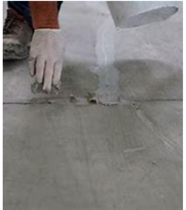
Fig. 11: Fotografía de la reparación de una fisura pasiva
