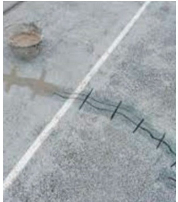
Fig. 7: Fotografía de la reparación de una fisura activa
