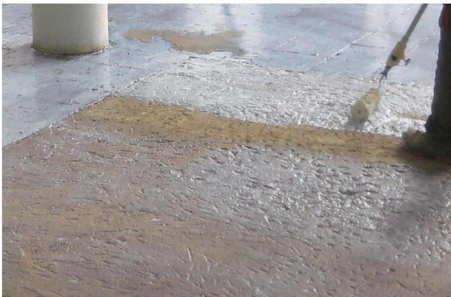
Fig. 20: Imprimación PROPAM® PRIMER SOL
