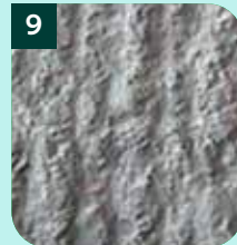
Fresado profundo o con picas medio
