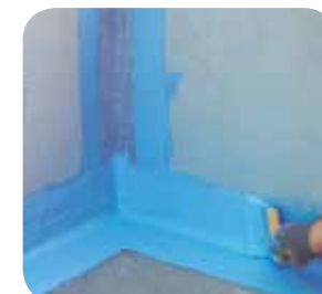
4 Aplicación de capa de PROPAM® IMPELÁSTIC sobre la superficie vista de BETOTAPE SEAL.
