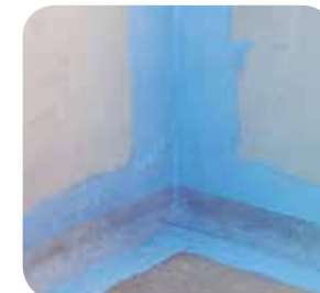
2 Fijación de la banda BETOTAPE SEAL en el encuentro suelo-pared.
