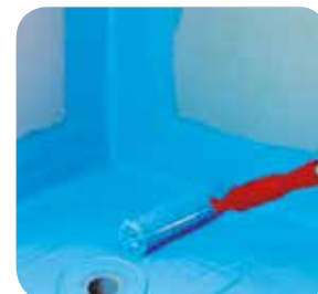
5 Impermeabilización de soporte horizontal con PROPAM® IMPELÁSTIC.
