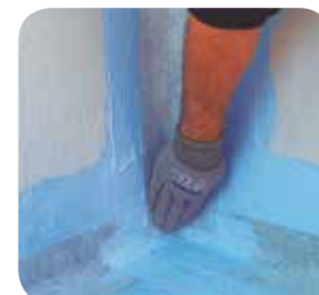
3 Fijación de BETOTAPE SEAL en posición vertical en el encuentro pared-pared.
