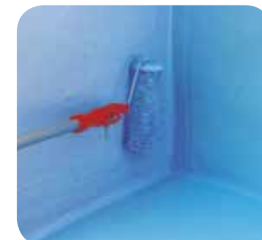
6 Impermeabilización de soporte vertical con PROPAM® IMPELÁSTIC.
