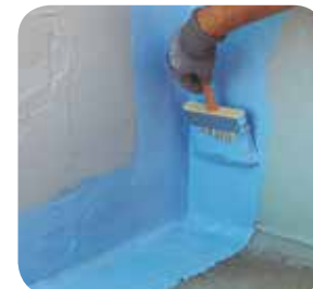
1 Realización de media caña y aplicación de base con PROPAM® IMPELÁSTIC.
